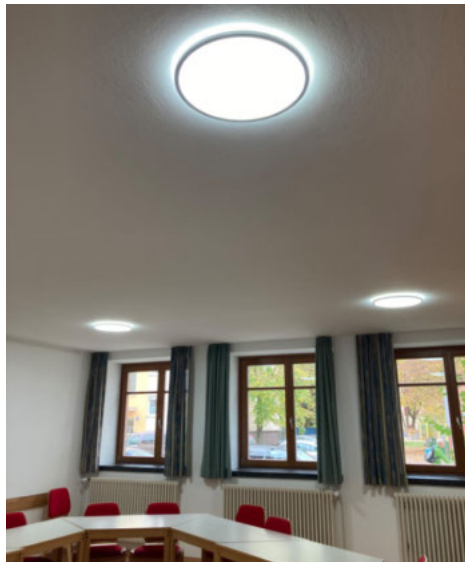
Als jüngste Aktion wurde die Beleuchtung im Raum 1 des Gemeindehauses erneuert und auf LED umgestellt.
